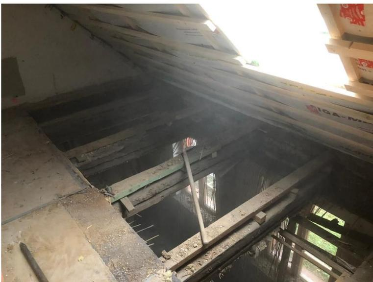
*In der hinteren Hälfte des Pfarrhauses müssen die Deckenbalken zwischen Erdgeschoss und Dachgeschoss erneuert werden.
