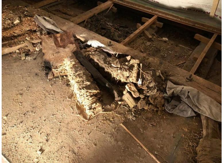
*Früher wurde mit solchen Lehmwickeln isoliert. Heute wurde das Dach mit „Isoflock“ ausgeblasen, um eine energiesparende Dämmung zu erhalten*
