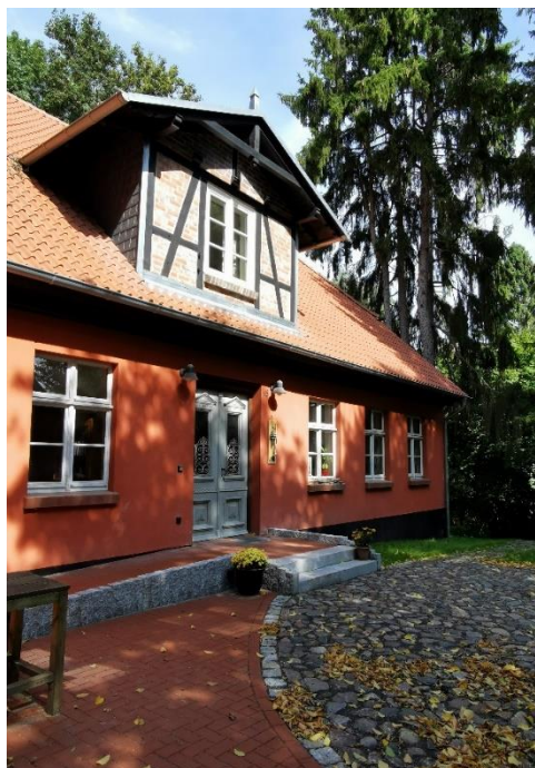
Auch der Vorplatz und der Weg zum Alten Pfarrhaus wurde neu gepflastert und eine Rampe zum Eingang gebaut
